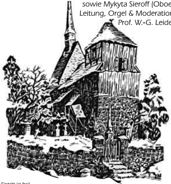
Kirche zu Graitschen, vor dem Umbau 1910
